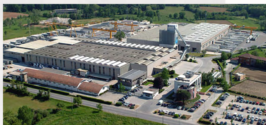
Impianto di prefabbricazione Magnetti
