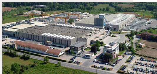
Impianto di prefabbricazione Magnetti Building
