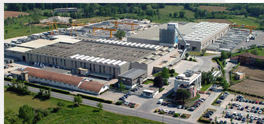
Impianto di prefabbricazione Magnetti Building
